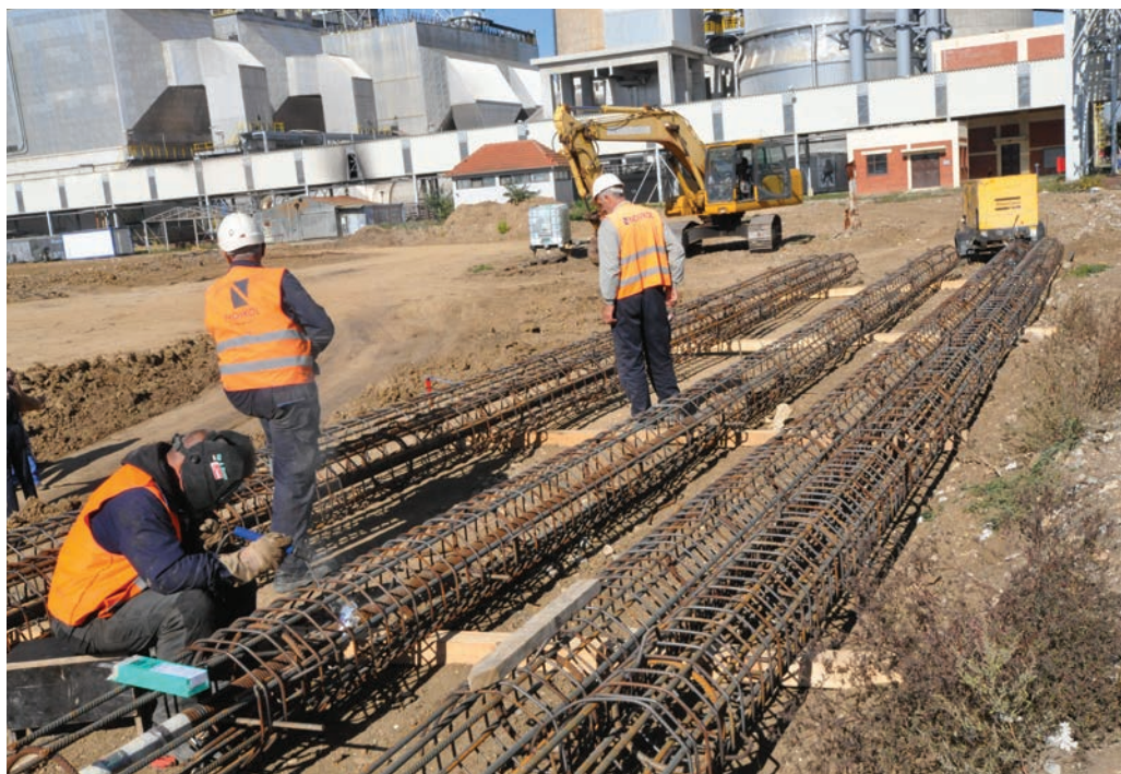
■ На градилишту блока Б3
