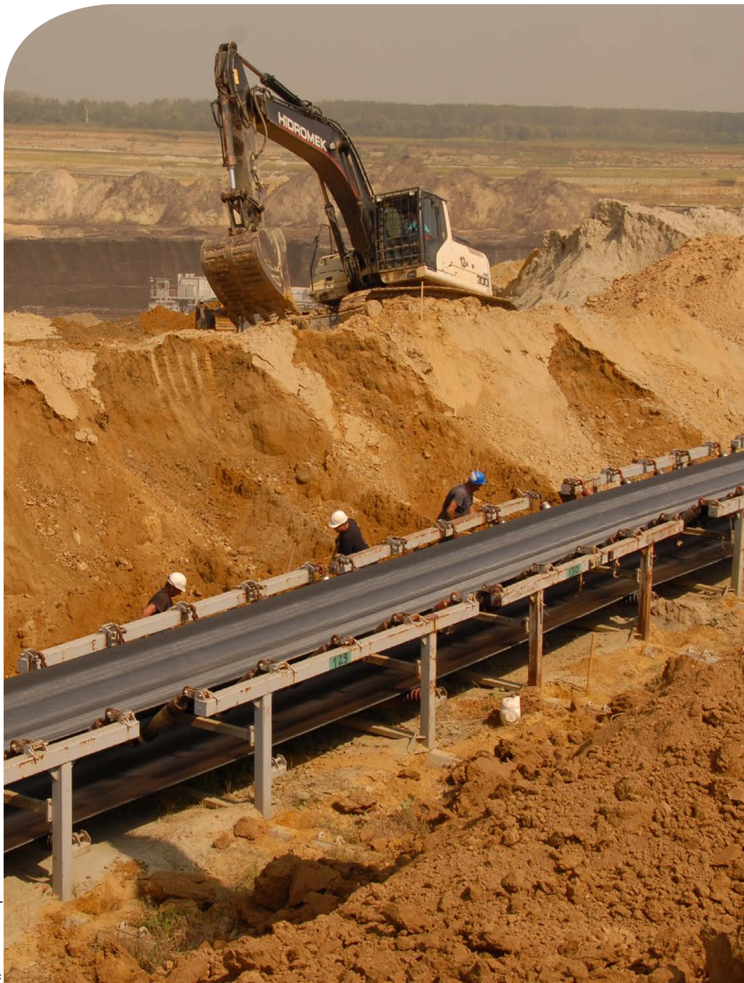
■ Обимни радови током ремонта на Површинском копу „Дрмно“
